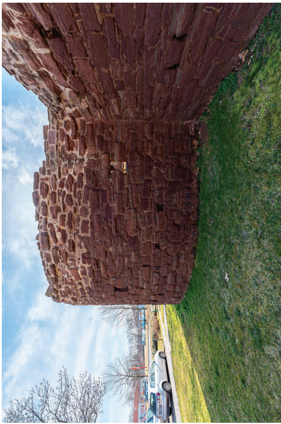
5. Bašta C, v horní třetině patrná nedávná úprava s výrazně světlejším spárováním, zdívo oproti nárožní baště dochováno ve výrazně lepším stavu vlivem nižší urovně terénu na rubové straně
