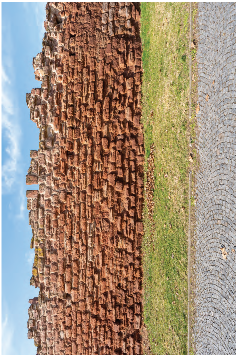
3. Úsek BC, kurtina mezi baštami, v horní části patrná úprava koruny zdiva z posledního zásahu, v horizontální linii patrné dvě řady otvorů pro trámy podsebití (?)
