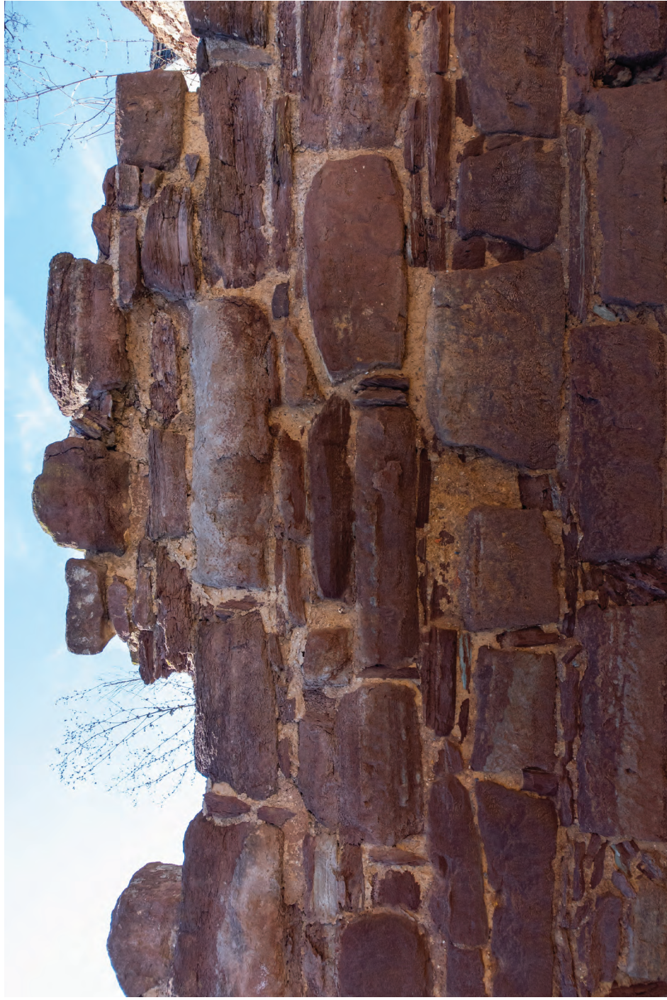
22. Úsek D, detail stavu kamenů zdiva
