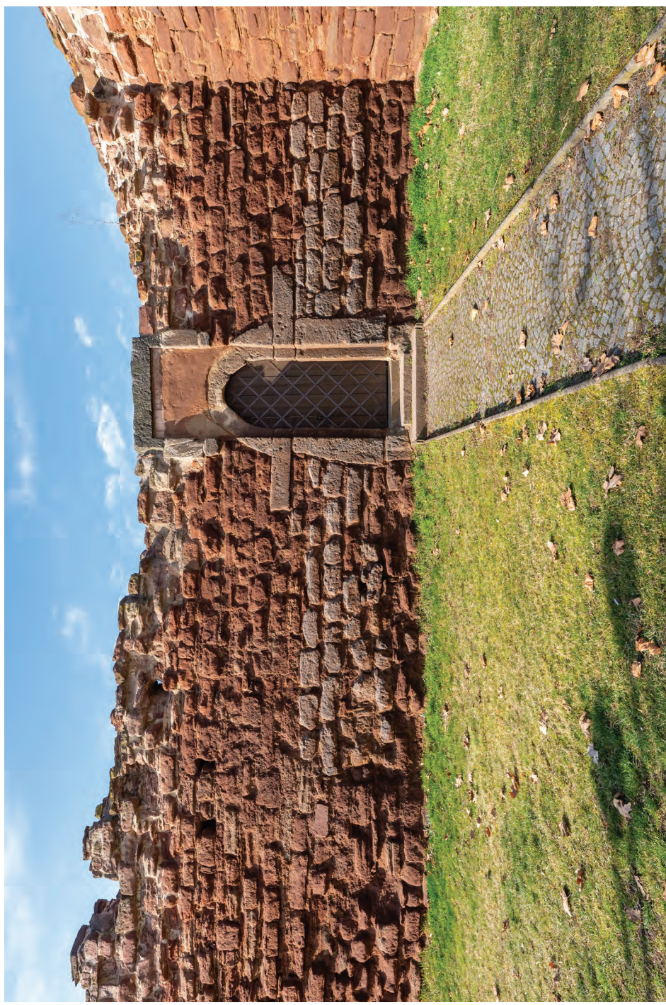
3. Úsek BC, kurtina mezi baštami, v horní části patrná úprava koruny zdiva z posledního zásahu, v horizontální linii patrné dvě řady otvorů pro trámy podsebití (?)
