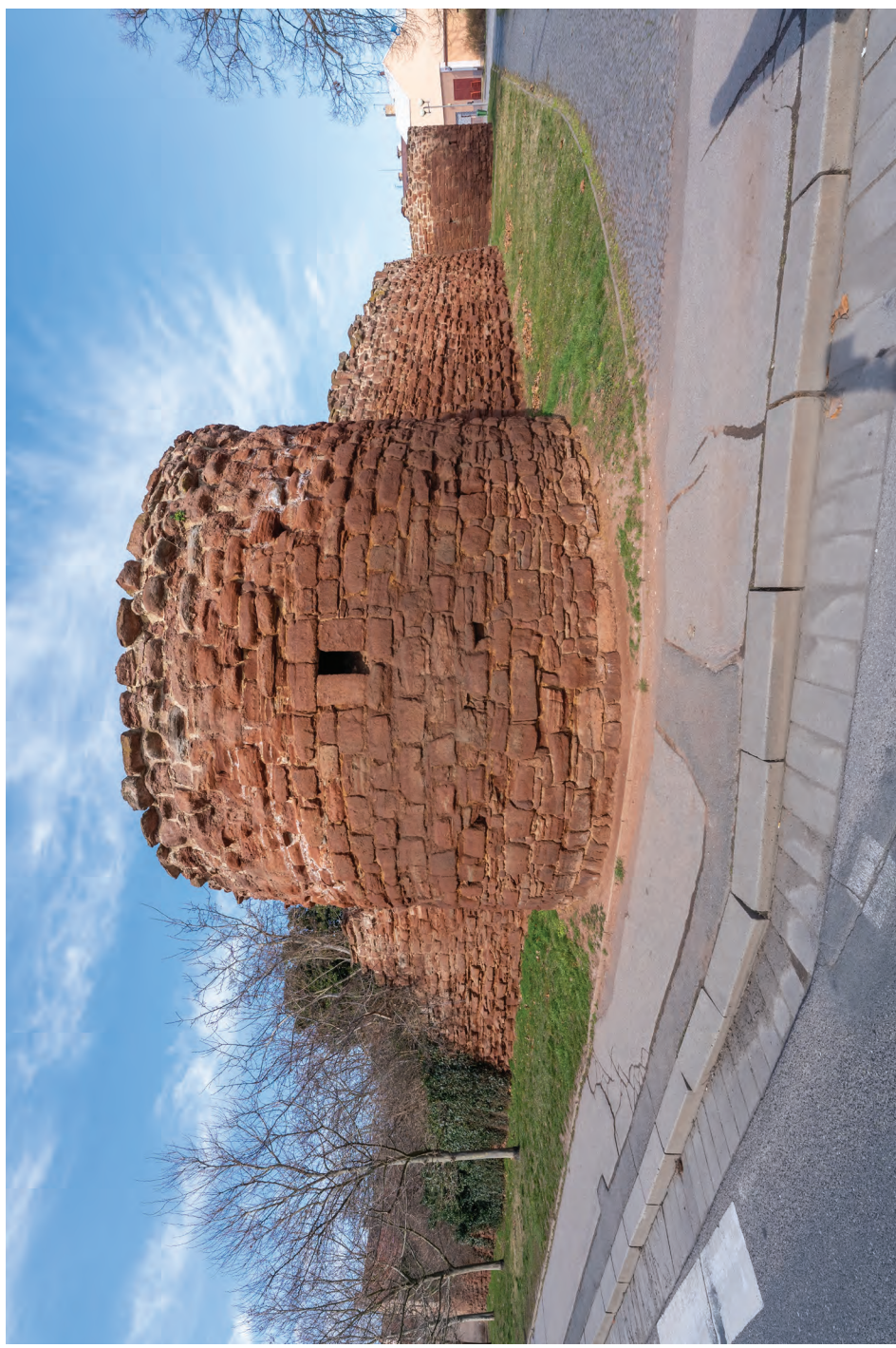
1. Bašta B, JV nároží, celkový pohled, v horní třetině patrný výrazný úbytek kamenné hmoty v důsledku rekrystalizace soli.
