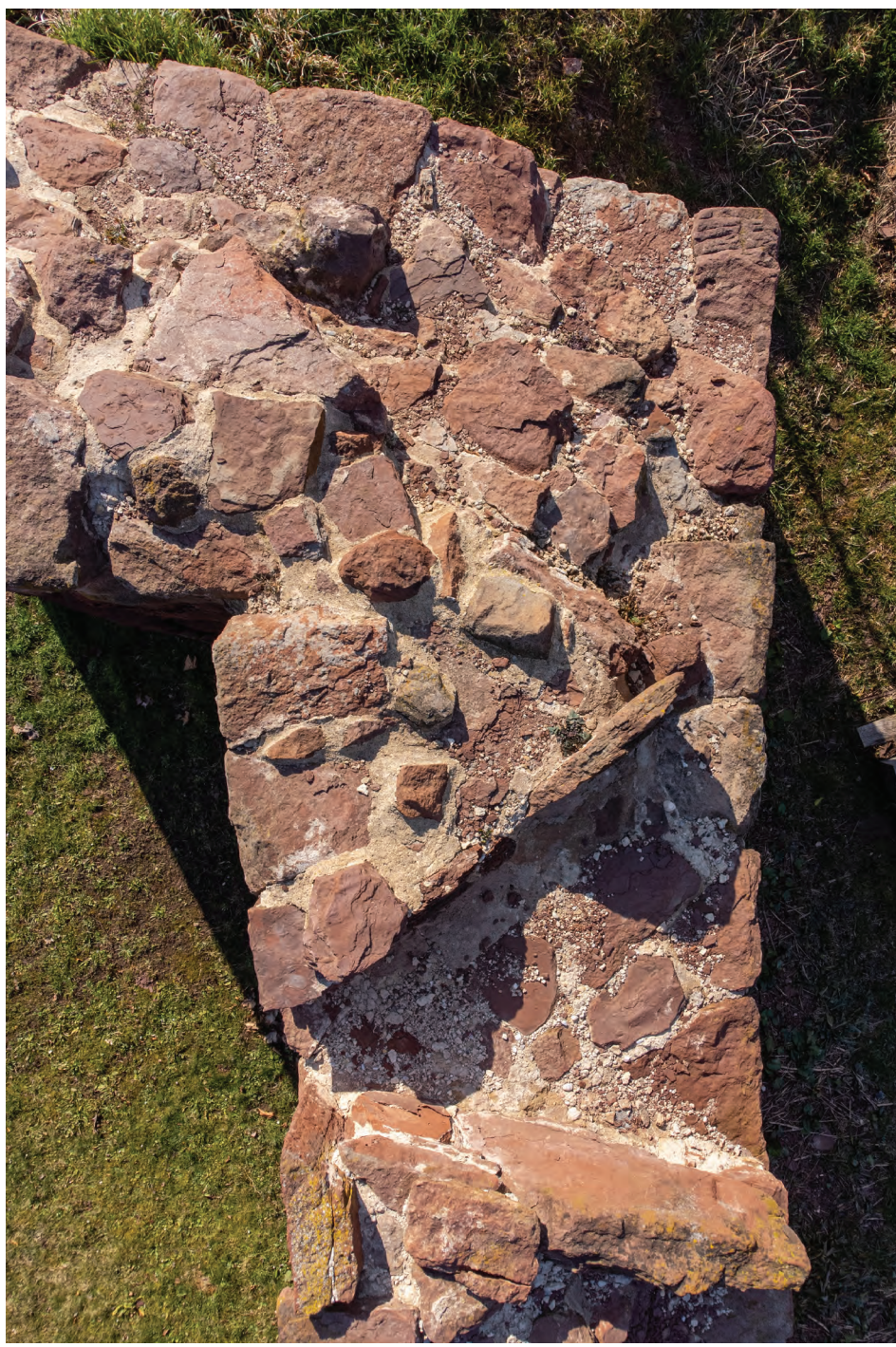
13. Nároží Bašta B/úsek BC, nově rekonstruovaná střílna, nálevkovitý typ, zcela destruované omítkové plochy
