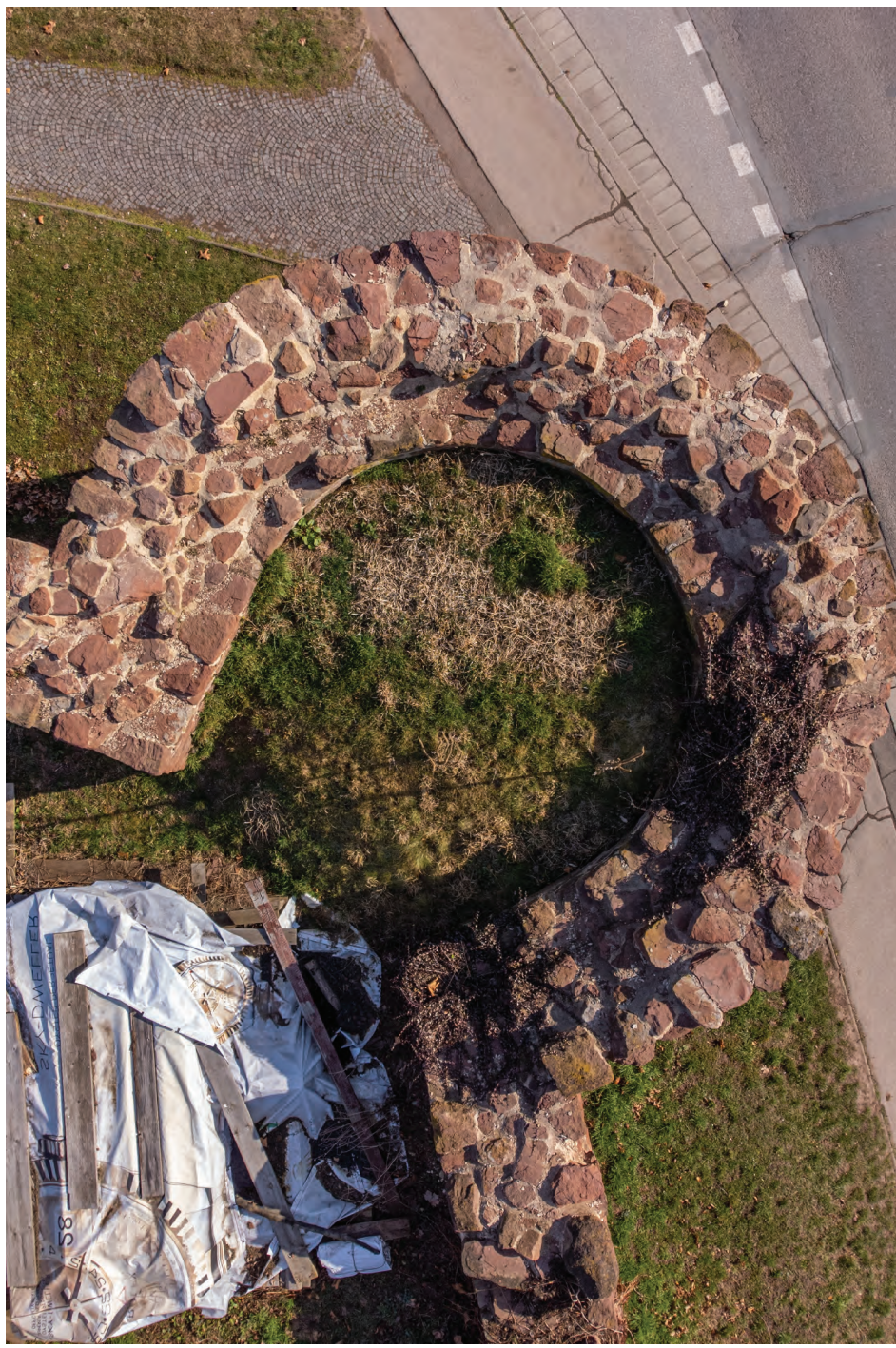
11. Bašta B, pohled na korunu zdiva nově omítnutou při poslední rekonstrukci
