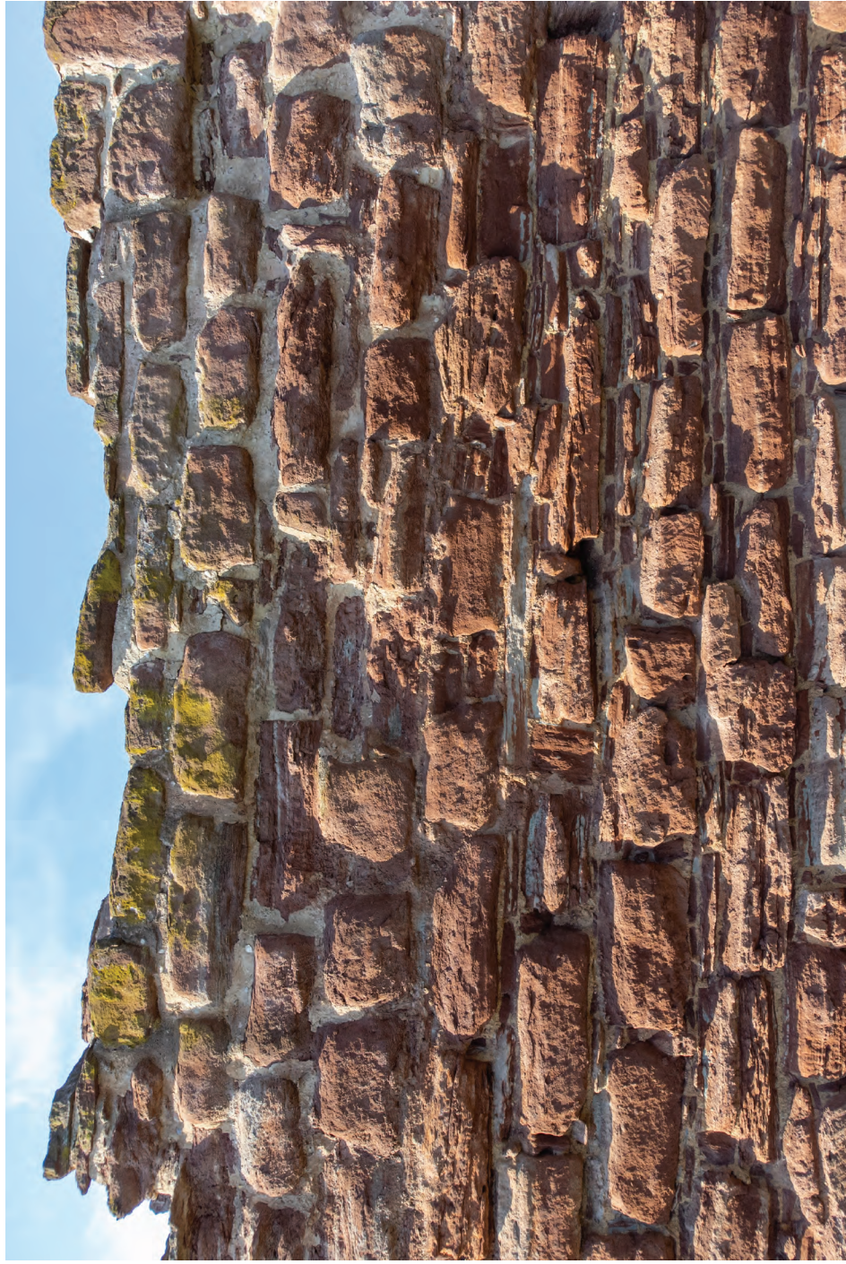
21. Úsek BC, detail stavu kamenů zdiva
