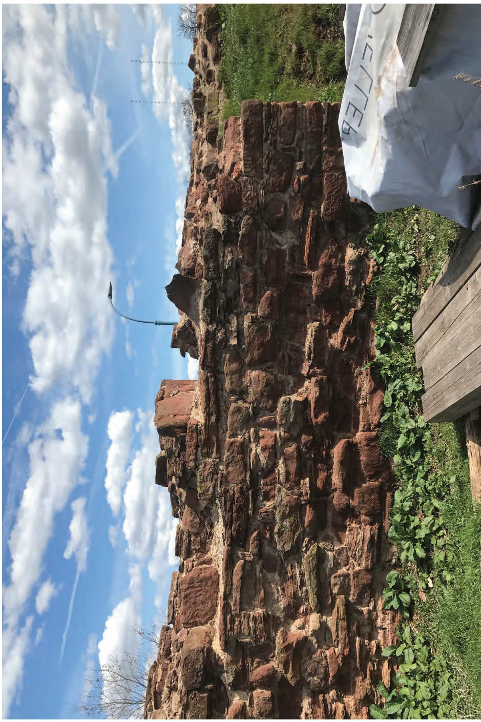
7. Úsek D, patrné dvě řady otvorů pro trámy, horní třetina upravena při posledním zásahu, stav kamene i nových spár oproti úseku A, baště B a úseku BC je výrazně lepší
