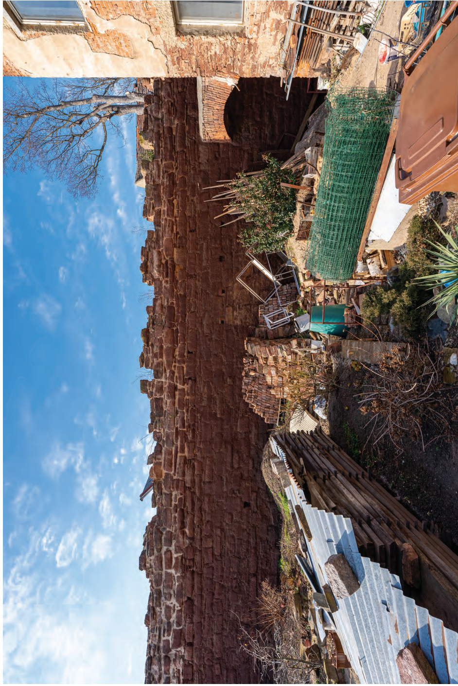
19. Úsek D, zavhlčení zdiva pod úroveň nově opravené koruny zdiva
