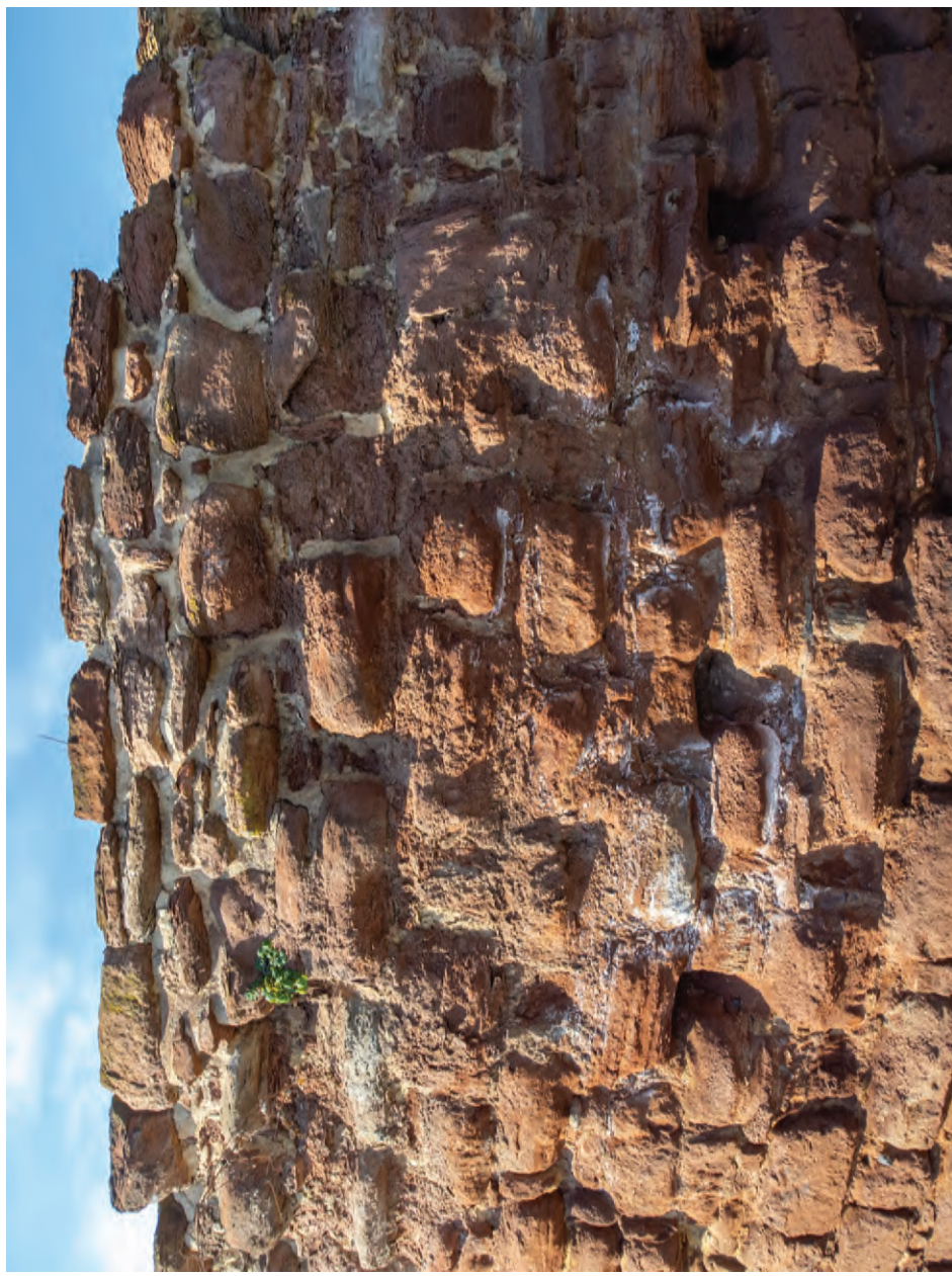
18. Bašta B, masivní úbytek hmoty zdiva a výkvěty solí v horní třetině bašty
