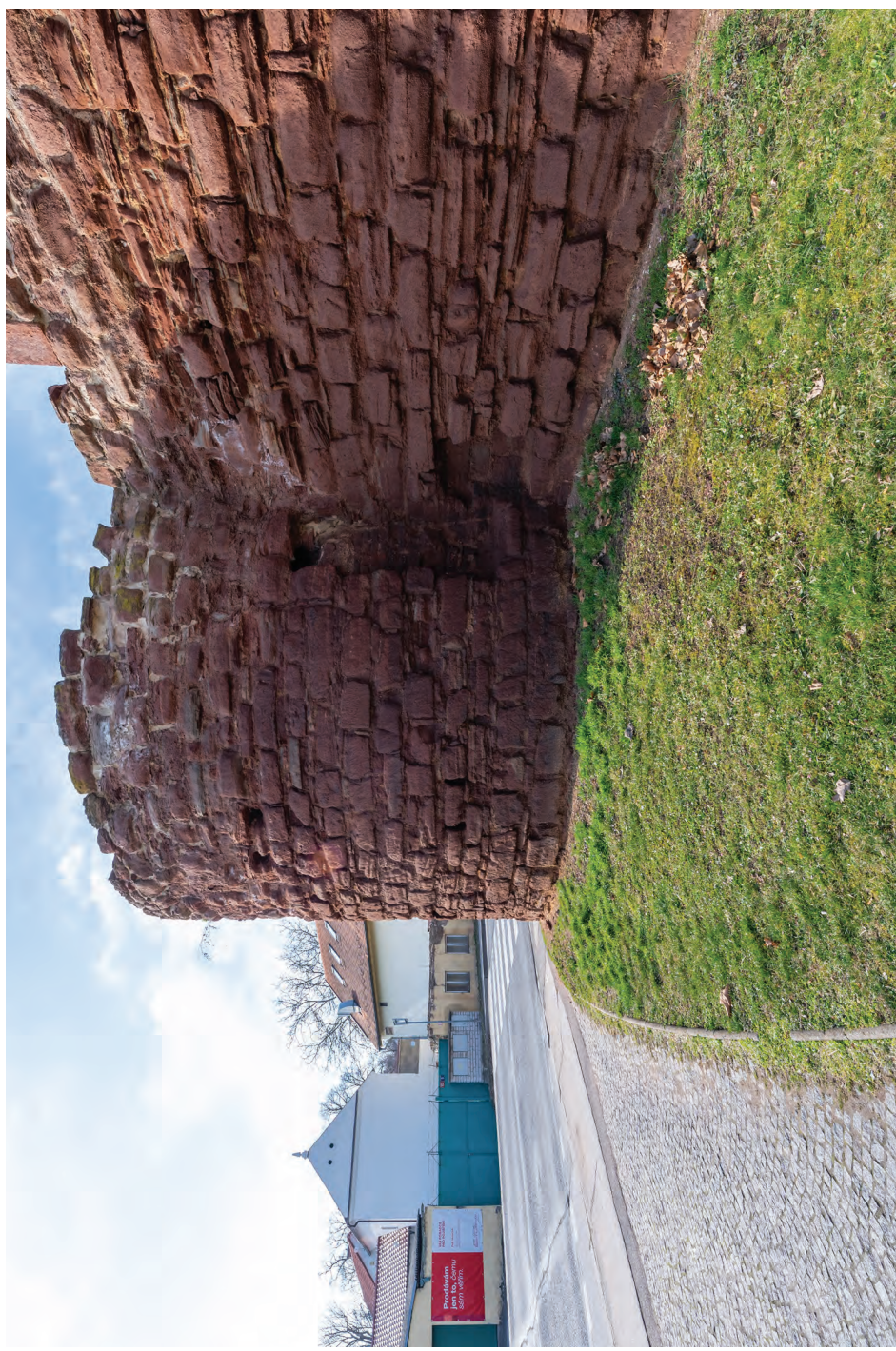
1. Bašta B, JV nároží, celkový pohled, v horní třetině patrný výrazný úbytek kamenné hmoty v důsledku rekrystalizace soli.
