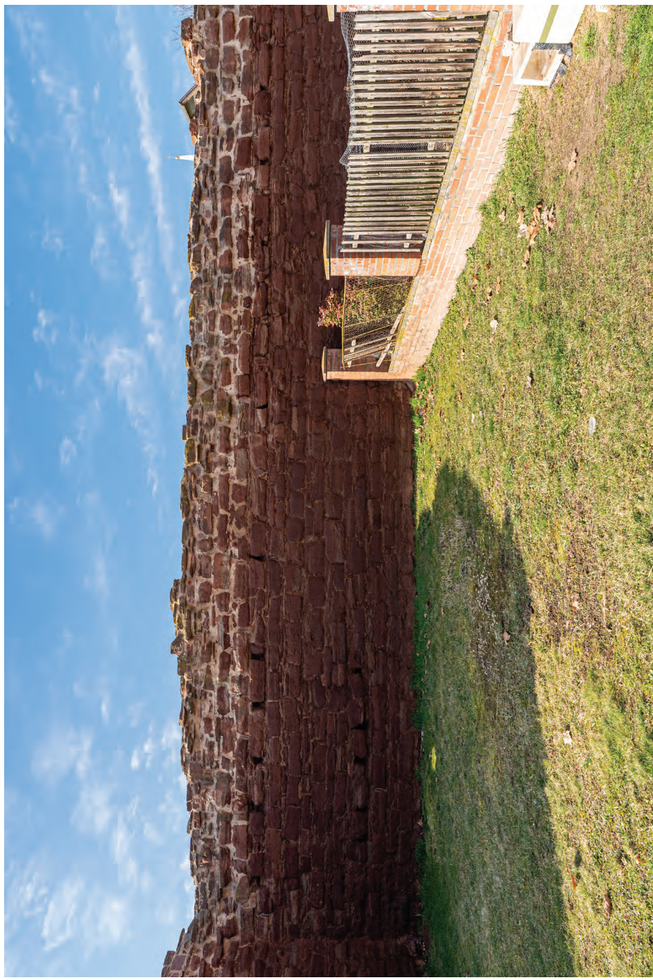
7. Úsek D, patrné dvě řady otvorů pro trámy, horní třetina upravena při posledním zásahu, stav kamene i nových spár oproti úseku A, baště B a úseku BC je výrazně lepší
