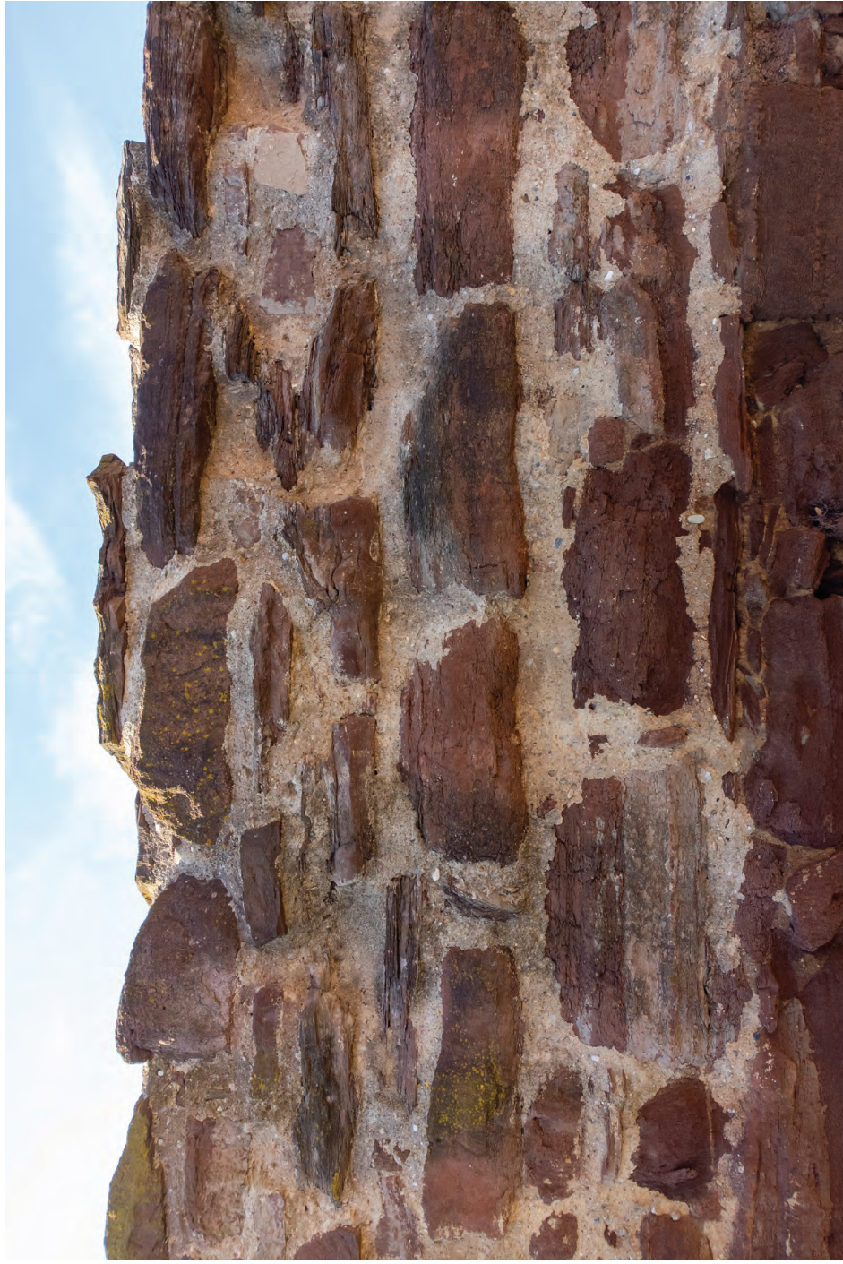
20. Úsek D, detail nově provedených výplní spár bez výraznějšího poškození
