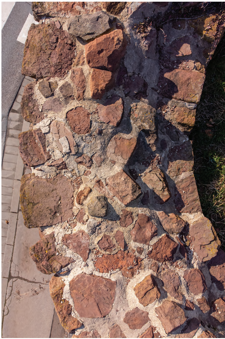
12. Detail předchozího, poškození nově provedených omítek a nově vezděných kamenů
