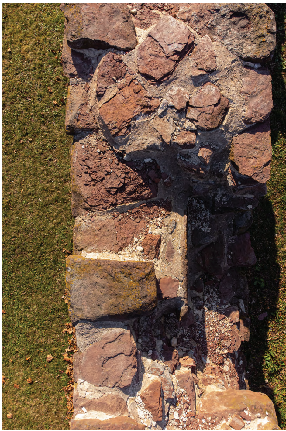
13. Nároží Bašta B/úsek BC, nově rekonstruovaná střílna, nálevkovitý typ, zcela destruované omítkové plochy
