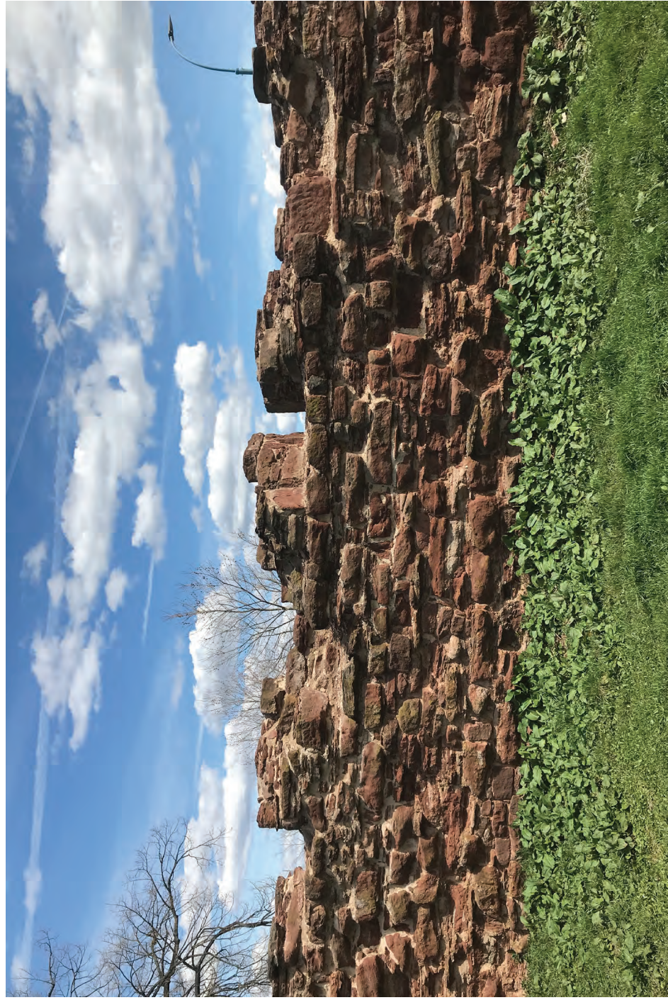
10. Rub zdíva v úseku BC, v horní části patrné naznačení střílen provedené při posledním zásahu
