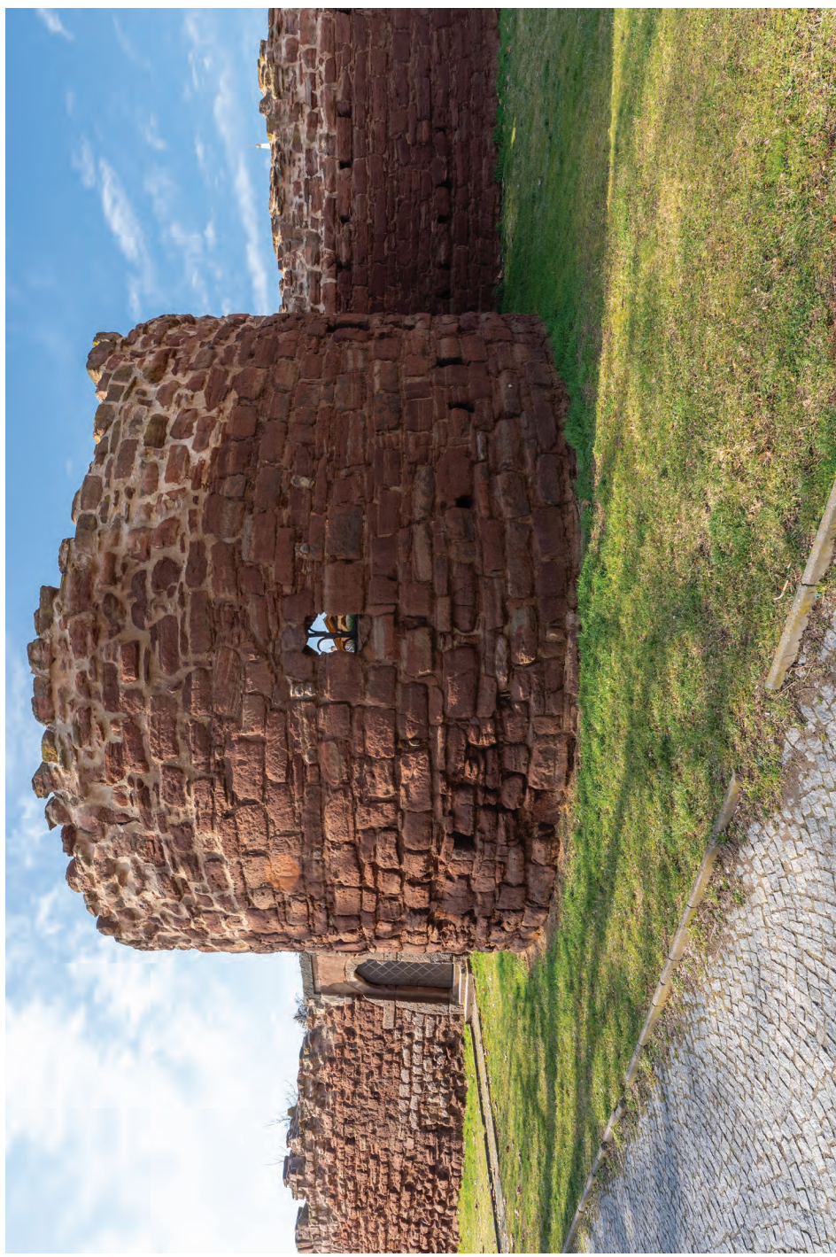
5. Bašta C, v horní třetině patrná nedávná úprava s výrazně světlejším spárováním, zdívo oproti nárožní baště dochováno ve výrazně lepším stavu vlivem nižší urovně terénu na rubové straně
